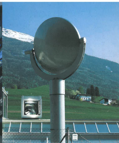
Eines der Kernthemen vom Bartenbach LichtLabor in Österreich ist die effektive Nutzung von Tageslicht. Oben: Ein Heliostat, mit dem das Sonnenlicht umgelenkt werden kann. Links: Die Norddeutsche Landesbank in Hannover.
